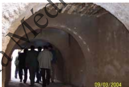
pl. V - Une sqifa : arc surbaissé avec passage voûté qui détermine une impasse. Celles qui ne possèdent pas peuvent être situées au niveau de la zone intermédiaire.
